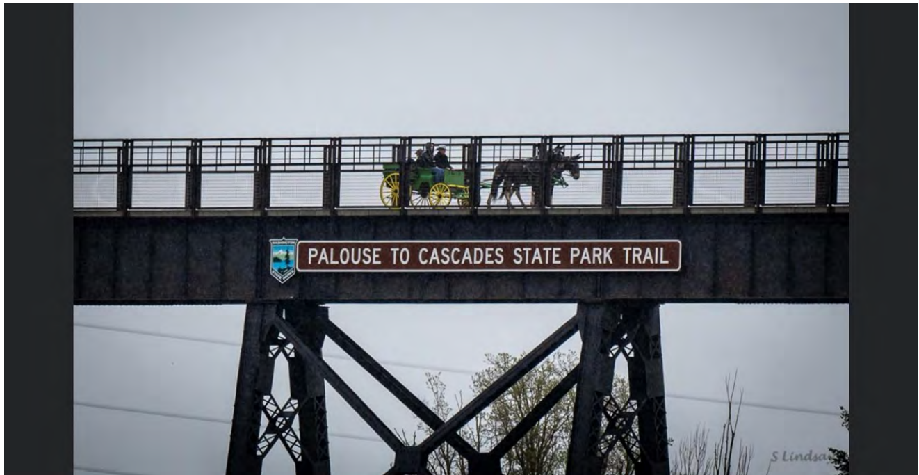
The Tekoa Trestle.
